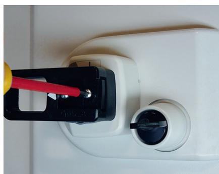
Adapter la longueur de l'axe suivant la distance porte-plastron/disjoncteur (se référer à la notice de montage de la commande rotative déportée).
