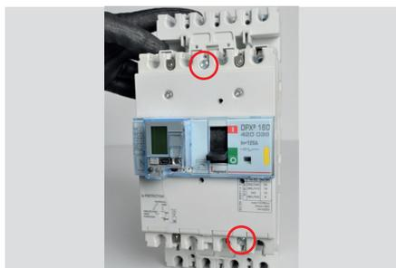
Fixer la pièce plastique noire sur le support à l'aide de la vis fournie puis insérer l'ensemble sur le disjoncteur.
